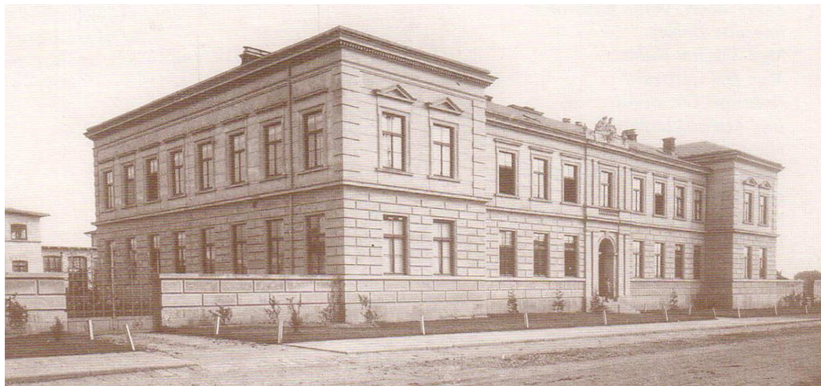
Školní budova po dokončení – rok 1891.
