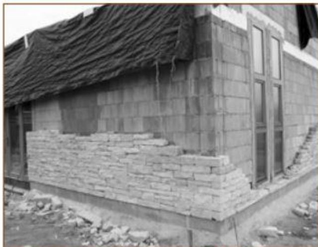
STAVBA odbavovací haly na autobusovém nádraží (snímek z 20. března 2020).
